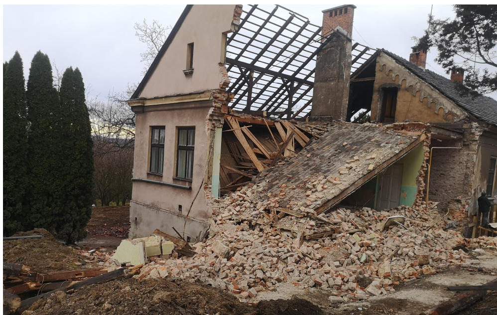
Fot. 7. Widok narożnika południowo – wschodniego podczas rozbiórki.
