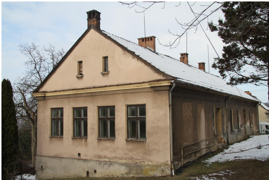
Fot. 1. Budynek usługowy przed remontem.
