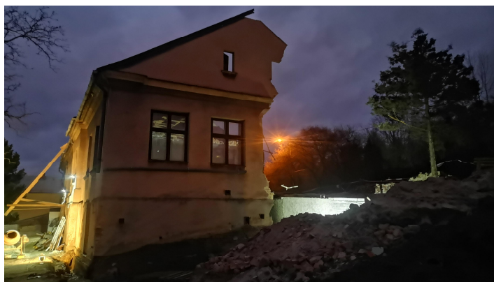
Fot. 4. Widok budynku częściowo-rozebranego.
