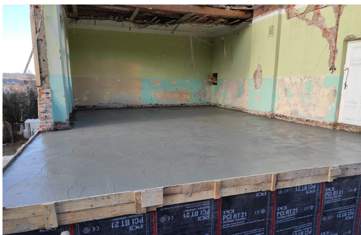
Fot. 9. Widok płyty żelbetowej na ścianach fundamentowych, izolacja przeciwwilgociowa.
