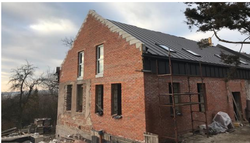
Fot. 10. Widok budynku w trakcie odbudowy.
