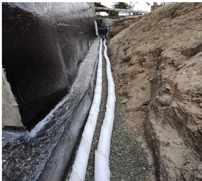
Fot. 8. Widok wzmocnienie ściany fundamentowej oraz podwójna opaska drenarska.
